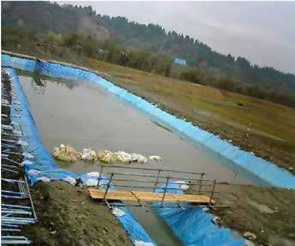
＜素掘による仮設沈殿池＞
