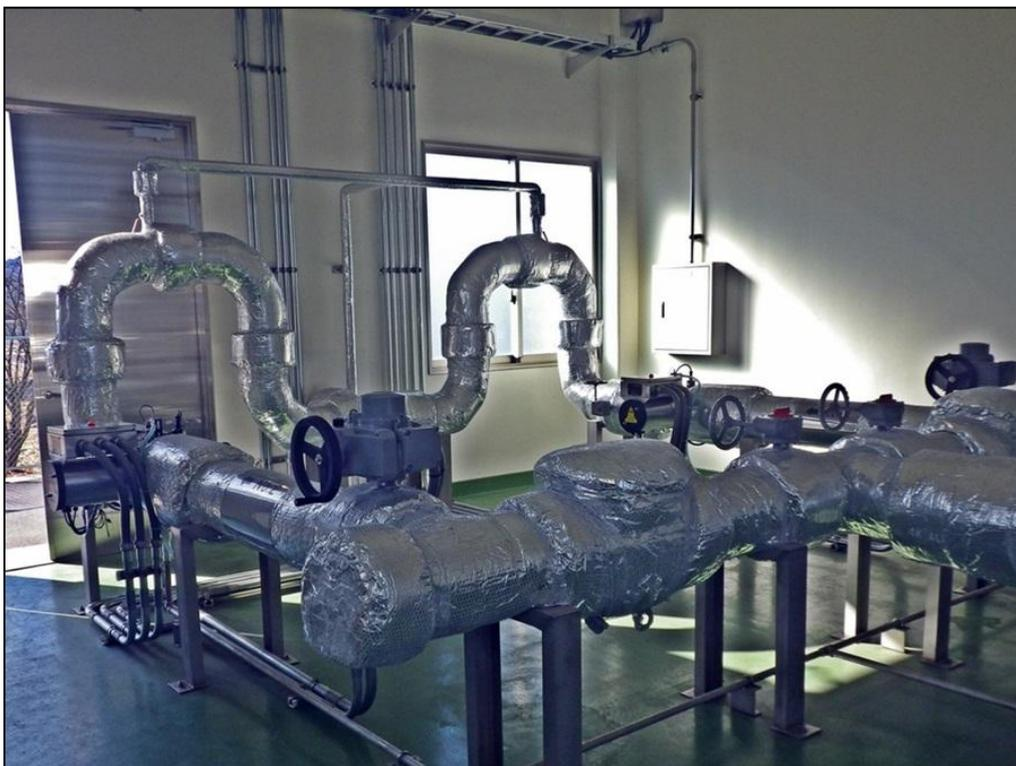
第2浄水場 紫外線処理装置
