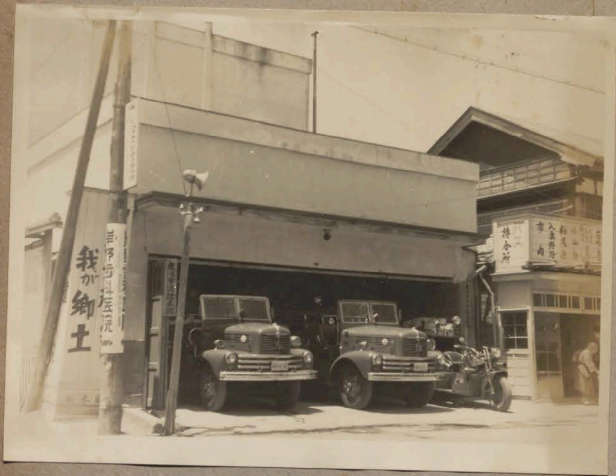
鹿沼市消防本部 現 駐車場
