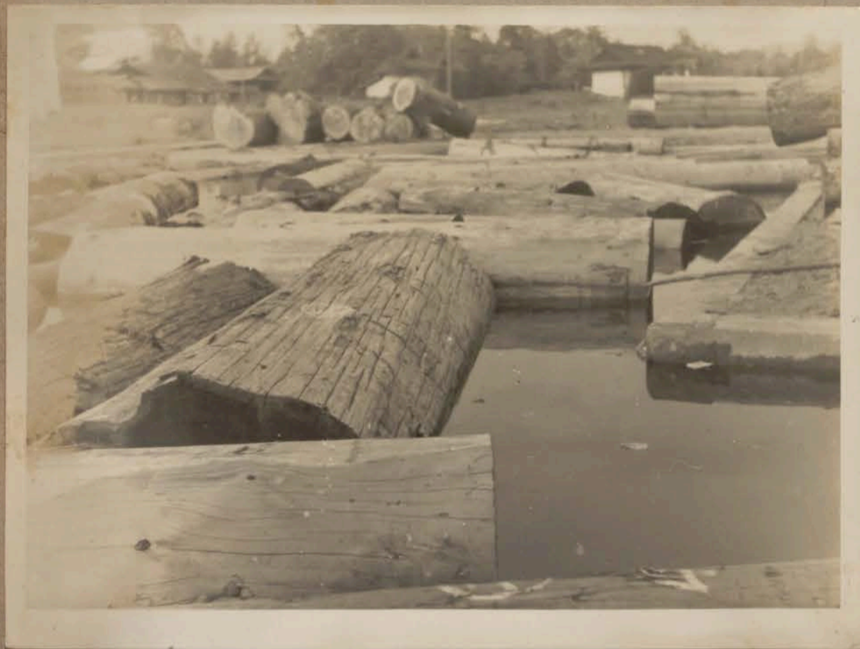
鹿沼市木材乾燥場貯木池
