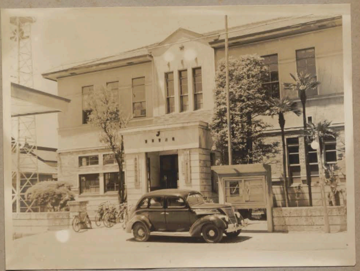
鹿沼市警察署 前 林業事務所 (文保所) 現 駐車場
