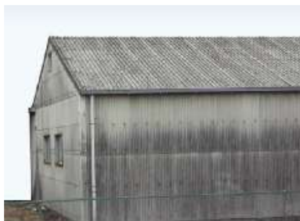
石綿含有スレート波板（屋根・外壁）
