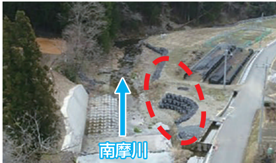
工事前 (令和3年3月撮影)
