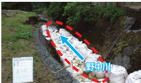
工事前 (令和2年3月撮影)
