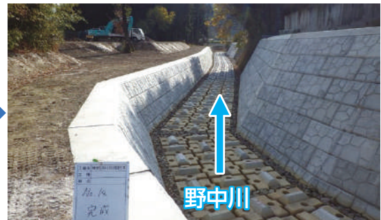
工事完了後 (令和3年3月撮影)
