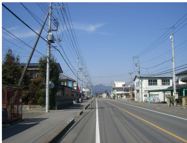
LED防犯灯を設置した主要道路
