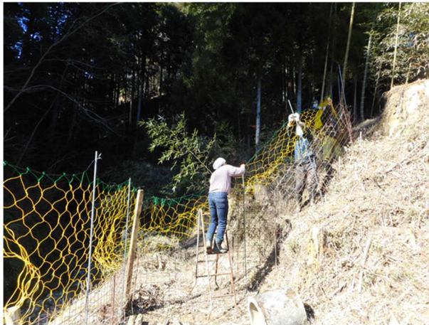
フェンス設置の様子
