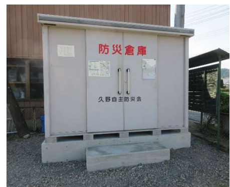
防災倉庫の嵩上げ
