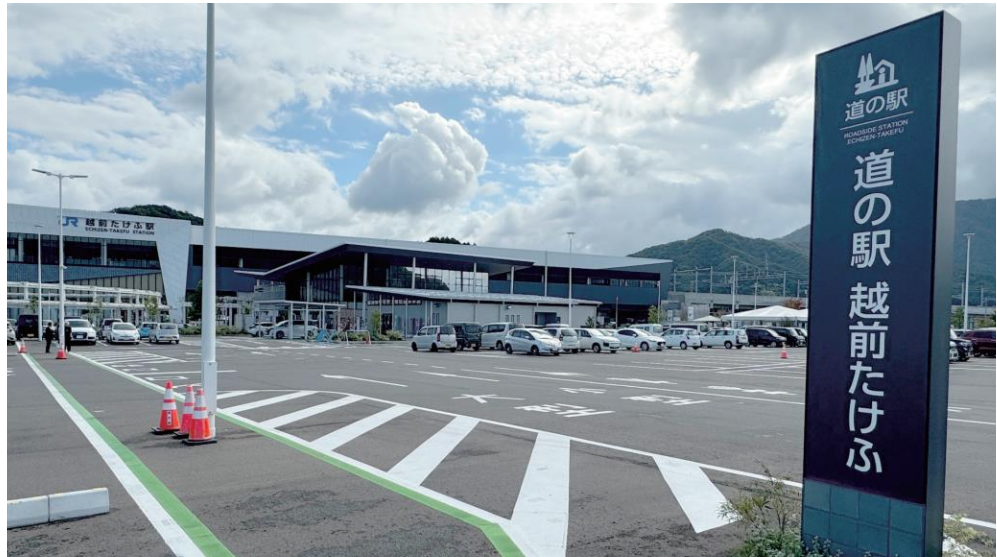
▲ 新幹線駅と駅ロータリー、道の駅と駐車場が、100ha の広大な敷地に一体となって整備が進められている
