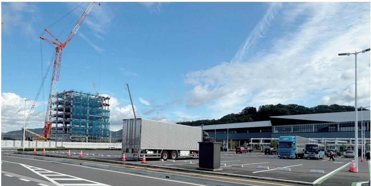
▲ 東側にはホテルが建設中
