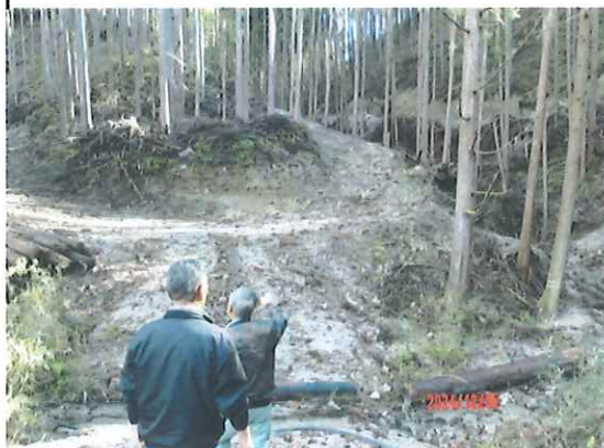
造成された仮設林道
