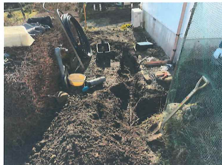
宅地内への取水工事も進んでいる
