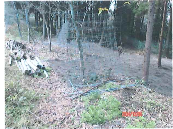
氾濫した際の柵被害と汚泥堆積
