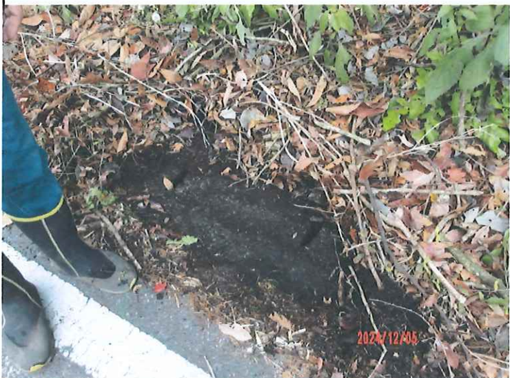
堆積した落ち葉を避けると側溝が確認できる
