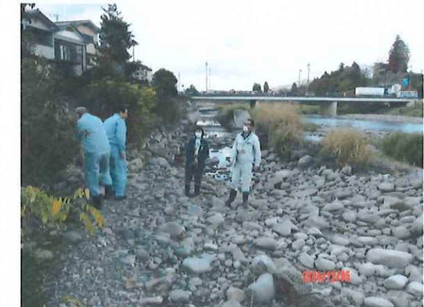
取水口の様子(護岸・堤防共に流出)
