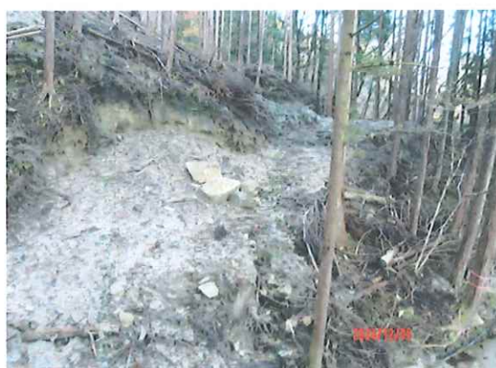
仮設林道の様子
