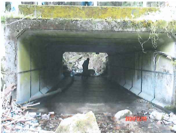
ボックス型のコンクリート作り
