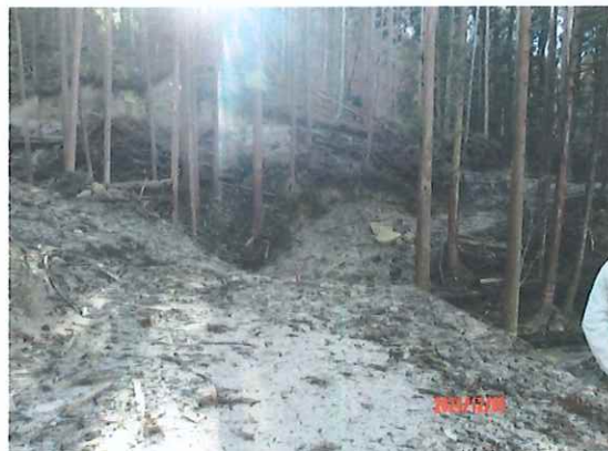
仮設林道の様子
