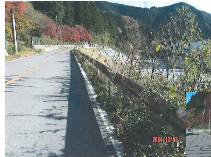
河川側ガードレール沿い
