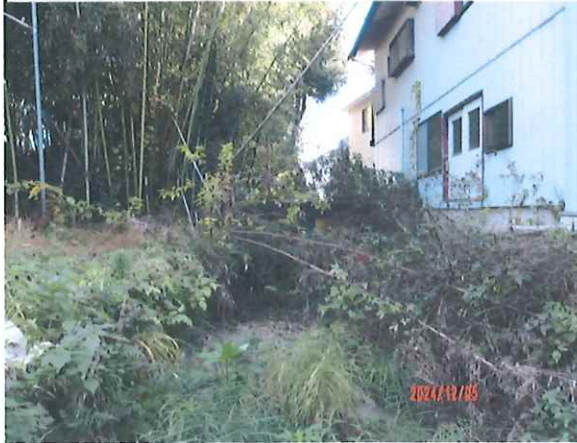
水門の北側より
