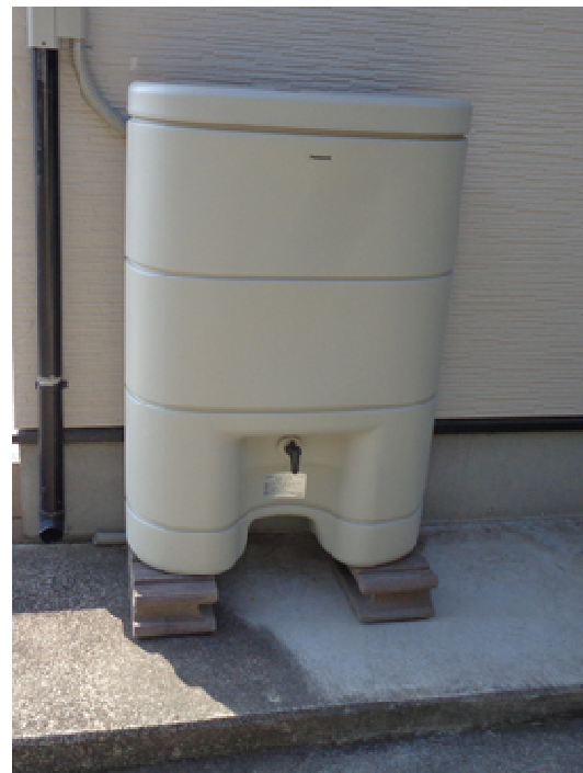
雨水貯留槽設置例
