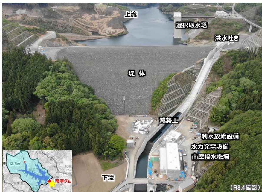
南摩ダム下流から上流を撮影
